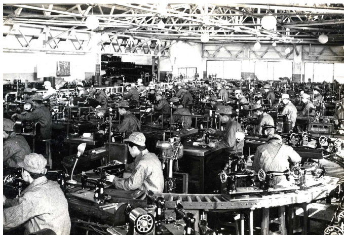
【写真2】 ミシンの組立工場 写真：ブラザーミュージアム提供
