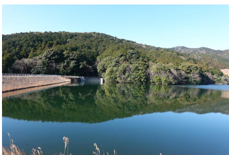
農業用水の水源となる宝地池（溜池） (左が堰高約 24m の堰堤、右端に新東名高速道路) (2023 年筆者撮影)
