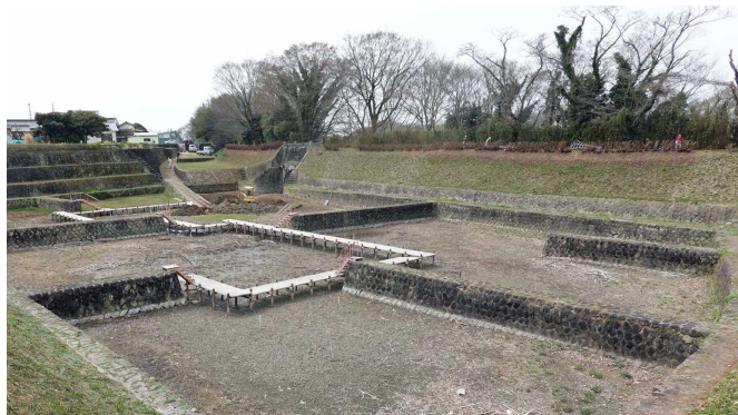
百々貯木場全景(堤防法面、樋門、池内の突堤は人造石で建設) (右側の堤は矢作川沿い、2023 年筆者撮影)
