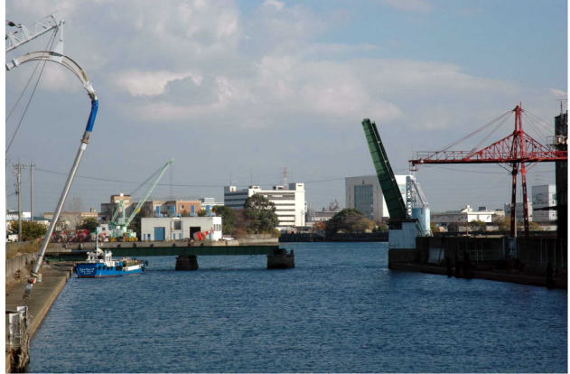
東神倉庫(現三井倉庫)が掛けた1-2号地間鉄道可動橋
