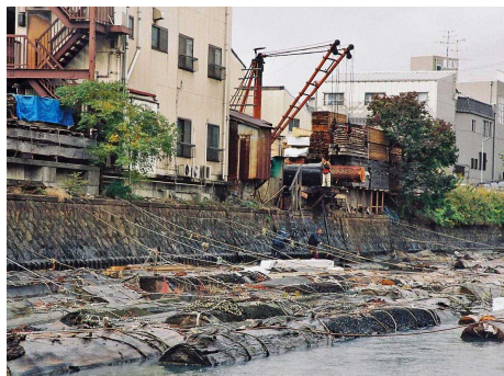
堀川沿いのデリックによる作業風景 (中区柳川町、2002年筆者撮影)
