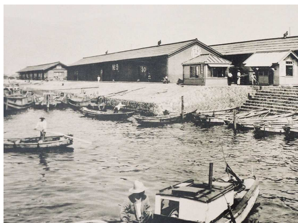
昭和初期当時の名古屋港2号地の人造石護岸及び人造石の物揚場と階段（『名古屋港写真帖』（昭和3年）より）
