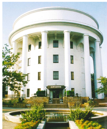
旧稲葉地配水塔 筆者撮影
