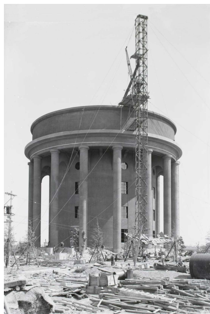
建設中の稲葉地配水塔 提供：水の歴史資料館
