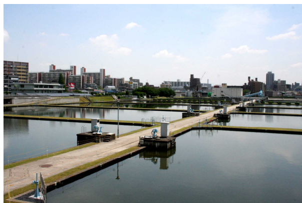
〔写真1〕現在の鍋屋上野浄水場の緩速ろ過池 2008/06/01 筆者撮影
