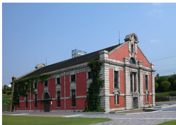
〔写真2〕鍋屋上野浄水場旧第1ポンプ所 2005/07/08 筆者撮影
