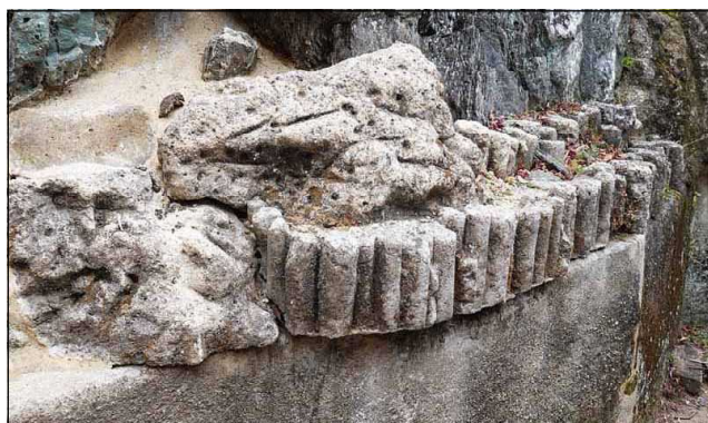
写真13 北池西側のたたき製の護岸の上に施工されるたたき製の擬石、擬木(2025.1.31筆者撮影)
