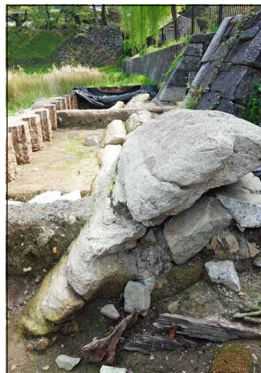
写真9 埋立地北側のたたき構造物と鉄製ボルト付きの木枠と思われる板が残る(2025.4.19筆者撮影)
