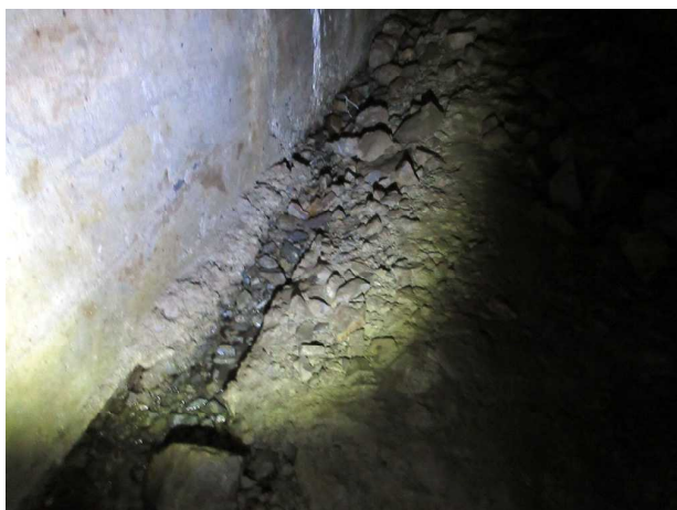
〔写真12〕大安寺西壕・北東部（コンクリート造の排水溝）
