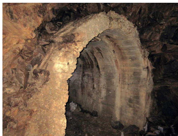
[写真7] 西壕・南西部(コンクリート造)東から
