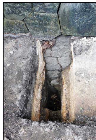
写真6 石垣下部まで厚みのあるたたきで施工が確認(2024.7.24筆者撮影)
