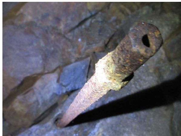
[写真6] 西壕・北東部にある削岩機用ロッド
