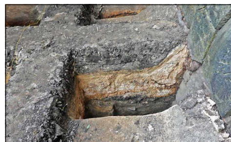
写真5 石積面と接する部分に丸みを付けて施工されるたたき(2024.7.24筆者撮影)
