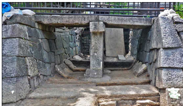
写真4 東口より見る水道内の全景、底は全面たたきで施工されていたことが判明(2024.7.24筆者撮影)
