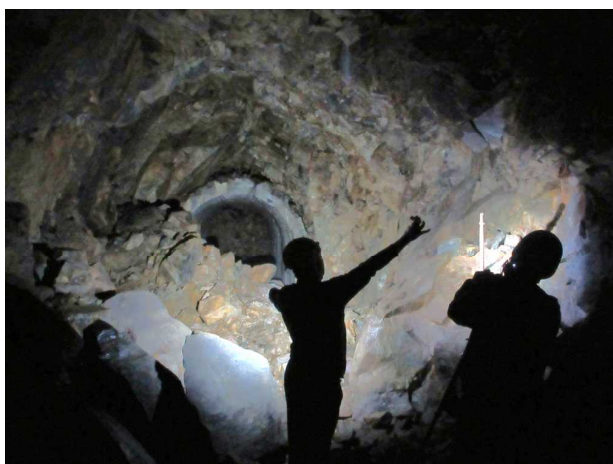
[写真4] 西壕・北東部の素掘り(奥穴はコンクリート造)
