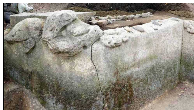
写真12 北池東側のたたき製の護岸、たたき製の擬石(2024.7.24筆者撮影)
