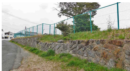
写真18 旧神野三郎宅の人造石擁壁 (2025.4.4筆者撮影)
