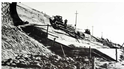
写真19 神野新田干拓堤防の人造石法面をコンクリートで嵩上げ(1953(昭和28)年工事) (出典:神野新田資料館展示パネル)
