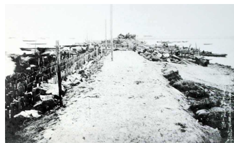
写真1 毛利新田堤防工事(1887年) (出典:神野新田資料館の展示パネル)
