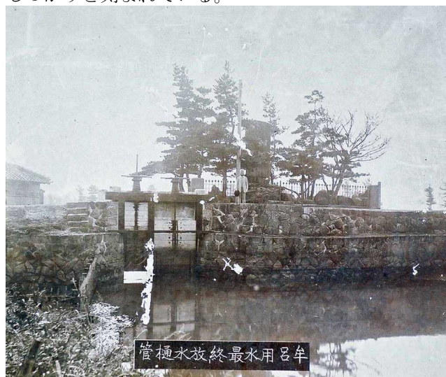
写真9 牟呂用水最終放水樋管とその脇に建つ紀徳碑(樋管と護岸は人造石で施工)(出典:牟呂用水土地改良区蔵)
