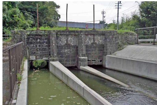
写真14 人造石の牟呂用水第5樋管(3水路に区分け、左側が野水用、遠景は東名高速道路) (2005.8.2筆者撮影、現状は今も不変)
