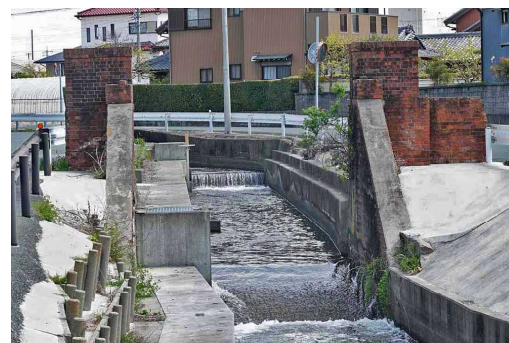
写真15 下流部の牟呂用水に造られた牟呂発電所跡(1896(明治29)年建設、右岸側に暗渠水路が付設)(2025.4.4筆者撮影)
