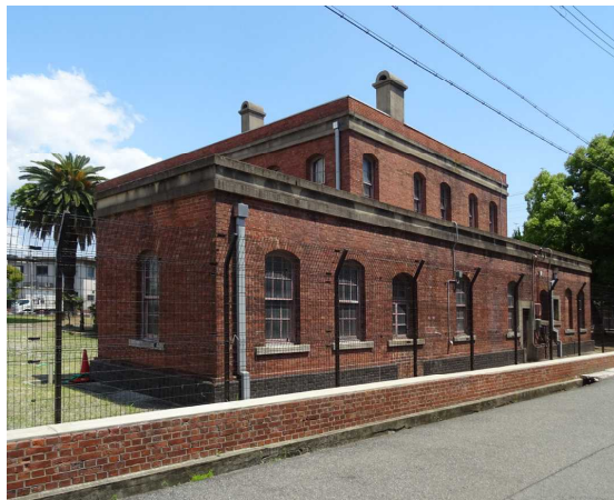
〔写真2〕建物の西側側面 （2024/06/07 筆者撮影）
