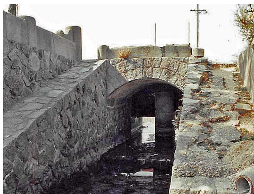
写真17 人造石の牟呂用水最終樋管(現在この前面にコンクリートの流出口が取り付け、現状景観は異なる、左側は紀徳碑の人造石擁壁と垣根) (1985.3.6筆者撮影)
