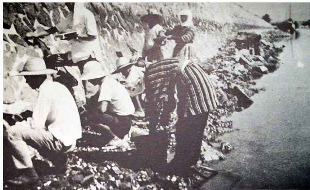
写真8 堤防人造石の目塗り (出典:神野新田資料館展示パネル)
