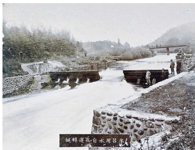
写真11 宇利川に掛けられた自在運轉樋 (左奥が牟呂用水の上流側、牟呂用水の流水を一旦宇利川に合流させ、右側にある牟呂用水の下流側水路に流し込む方式、護岸は人造石)(出典:牟呂用水土地改良区蔵)
