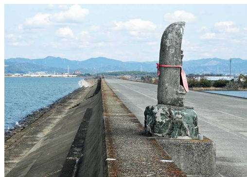
写真20 神野新田の4号堤防（人造石で建設当初の波返しの様子分かる、現在堤防は全てコンクリートで覆われる、隠れた人造石遺産の一つ、観音像は嵩上げ後に再安置） （2025.4.5筆者撮影）
