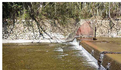
写真16 宇利川自在運転樋の人造石護岸 (2025.4.4筆者撮影)
