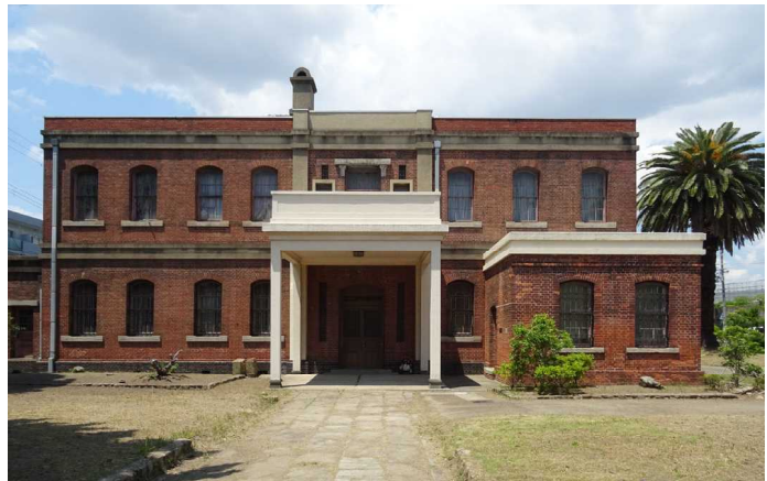
〔写真1〕旧尼崎紡績本社事務所 （2024/06/07 筆者撮影）
