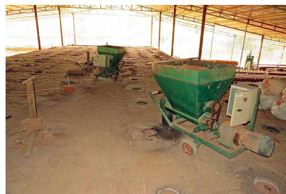
写真4 現在は閉鎖された窯屋上の大鋸屑投入口 (2018.12.26筆者撮影)
