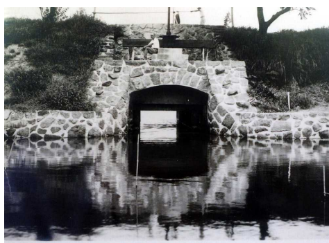
写真5 神野新田の2号樋門 (1950年人造石で北端に新たに肥料運搬を目的とした樋門が新設される (現在は閉鎖)。当初建設された 5 つの樋門はその後コンクリートで改修されたが、現在も同位置に存在する。
