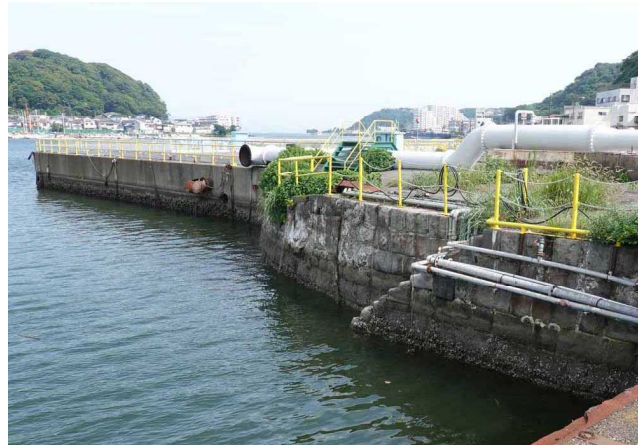
写真4 浦賀ドック脇の人造石護岸、階段付近の護岸壁面から人造石試料を採取(2021.7.21筆者撮影)
