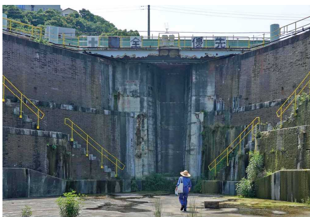
写真1 浦賀ドックの渠頭部分(2021.7.21筆者撮影)
