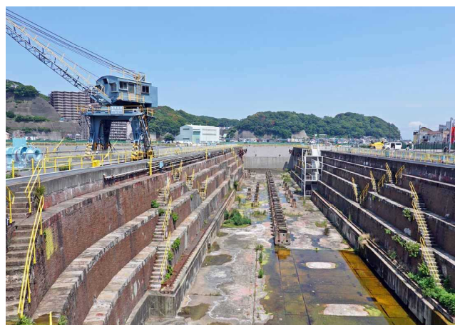
写真2 浦賀ドックの俯瞰(渠口方面を見る)(2021.7.21筆者撮影)
