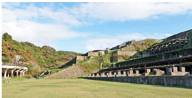
西側より見る北沢地区の旧北沢青化・浮選鉱所
