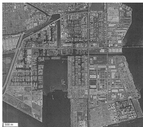
【写真2】貯木場運用最盛期頃となる 1987-90年の西部木材港の貯木状況（国土地理院地図航空写真より）
