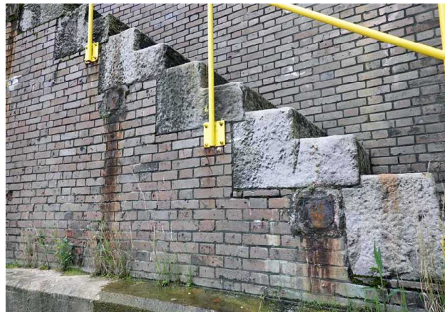
写真3 浦賀ドックの煉瓦造はフランス積み(2021.7.21筆者撮影)
