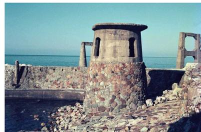
写真5 1993年当時の大間港の西側のクレーン台座(下部は人造石)、奥には人造石の突堤(1993.8.24筆者撮影)
