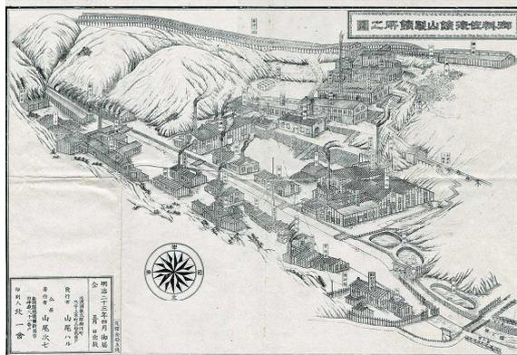
図9 沈殿池と推察される沈殿溜(右下の三つの円形及び細長い形状の池)。「御料佐渡鉱山製錬所之図」、相川郷土博物館所蔵)
