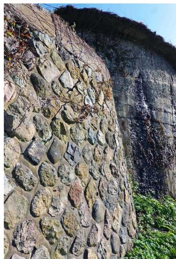
写真11 旧北沢青化・浮選鉱所の第2層西側擁壁(人造石の様相を示す)、右奥はシクナー
