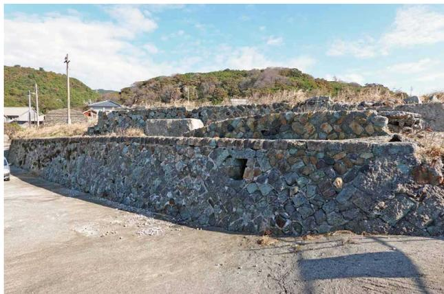
写真2 大間港の北側(相川漁港脇)の旧護岸(当初は海に面していた護岸)とその上に立つ副堤(2023.11.9筆者撮影)
