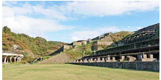
写真9 西側より見る北沢地区の旧北沢青化・浮選鉱所(正面奥)、正面の斜面は旧インクライン、右の建物跡は北沢浮遊選鉱場、濁川を挟んだ左は50mシクナー(2023.11.8筆者撮影)
