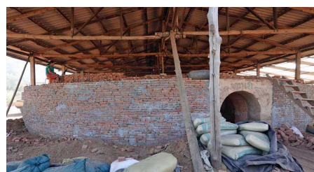
写真5 全面煉瓦で積まれた輪環窯の端の円弧部分外観、端には1か所の出入口が取り付け(2019.12.21筆者撮影)
