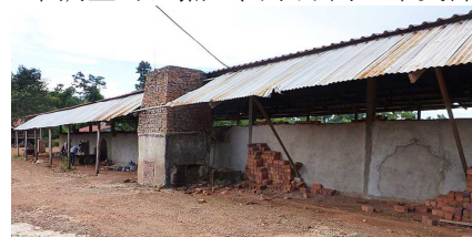
写真6 当初は輪環窯の外側に取り付けられていた煙突(2014.8.22筆者撮影)
