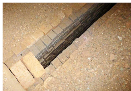
写真16 窯入れした煉瓦5000個ごと設ける15cmほどの隙間(2014.8.22筆者撮影)
