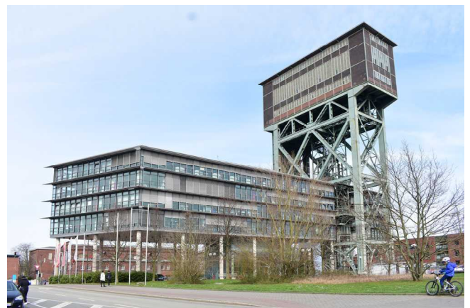
【写真1】 ミニスター・シュタイン炭鉱の立坑櫓 (2023/03/28 Mayer撮影)
