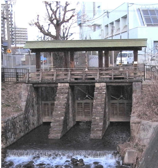
復元された黒川樋門
