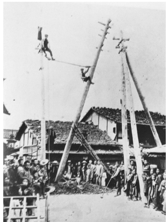
明治・大正時代の電柱を立てる工事
