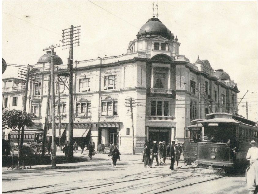
名古屋繁華街の電柱（木柱）
