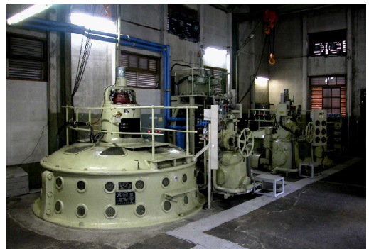
長篠発電所のドイツ製発電機 写真：筆者撮影
