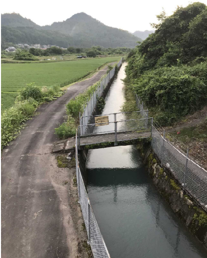
井ノ面発電所の導水路 写真：筆者撮影
