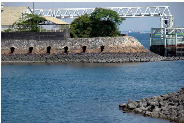
四日市旧港潮吹き防波堤
