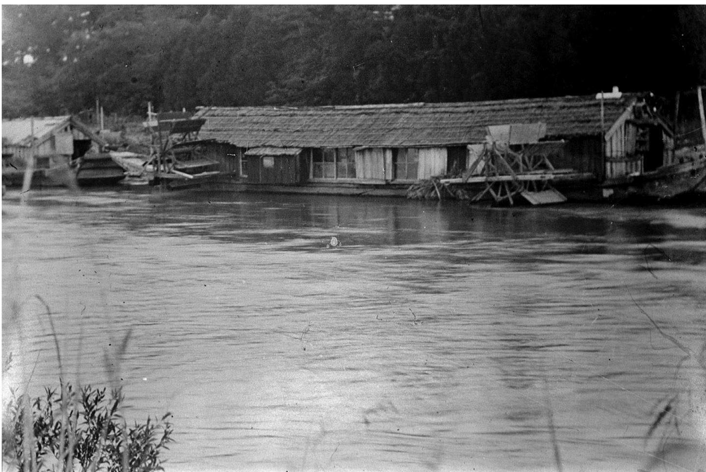
矢作川に浮かぶ紡績船。船は岸に固定し、川の流れで水車を回した。
