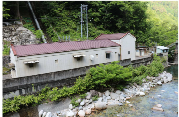
松川第三発電所 写真：市野清志撮影
