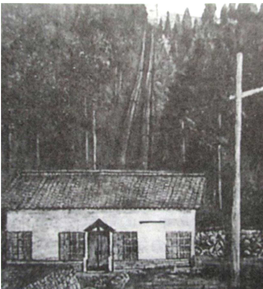
信濃電気が1904(明治37)年に建設した米子発電所(出力:120kW)、跡地脇に「米子発電所跡」の解説板が立てられている。
