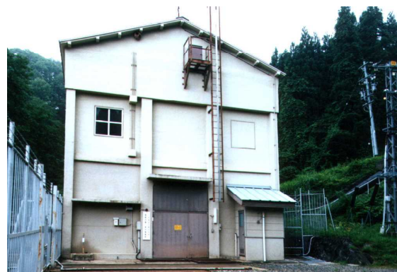
信濃電気が建設した鳥居川第一発電所(1925)
