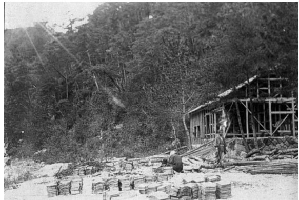
巖倉水力発電所の建設 出典：『田中善助伝記』1998
