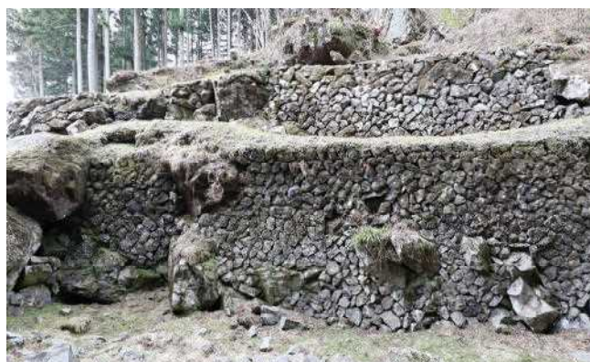
写真7 冷風の吹き出し口の石積み
