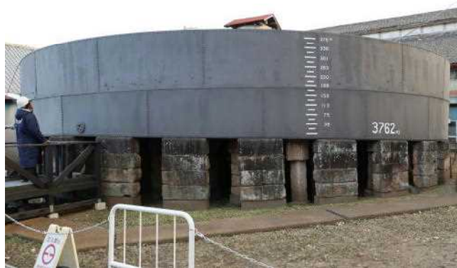
写真3「鉄水溜」は現存する日本最古級の鉄製構造物
