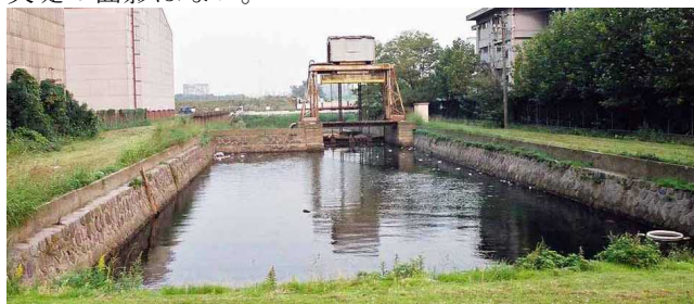
写真12 かつての8号地水中貯木場の第一閘門、閘室跡の人造石護岸(2000.11.7筆者撮影)
