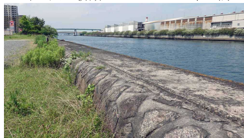
写真11 堀川左岸沿い(5号地)の人造石護岸、大正初期に嵩上げされた部分と思われる(2020.6.21筆者撮影)
