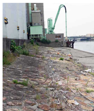
写真19 1950年の修繕工事と推測される10号地西側の人造石物揚場（2020.6.4筆者撮影）
