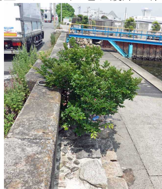
写真10 4号地南側の人造石の階段跡(手前)と仮棧橋脇に人造石護岸(2020.6.4筆者撮影)
