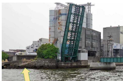
写真9 名古屋港跳上橋付近(2号地)の人造石の護岸と階段(割石間に土色のたたきの練土が見える、2020.6.4筆者撮影)
