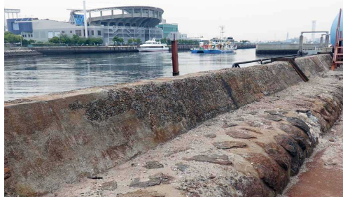
写真8 3号地南東側の人造石護岸(コンクリート防潮堤は後の工事、2020.6.4筆者撮影)
