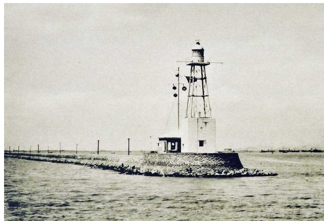
写真4 人造石で施工された西突堤の先端
