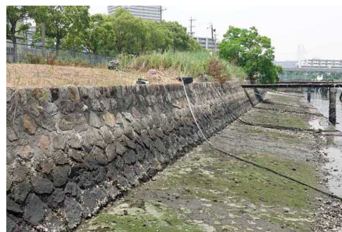
写真18 12号地東側の人造石護岸（北側の陸地方面を見る、西突堤と同じ位置に当たる） （2020.6.4筆者撮影）
