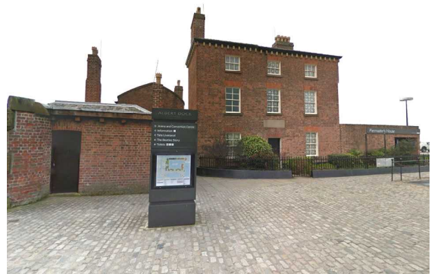
〔写真8〕 ピアマスターズ・ハウスThe Piermaster's House ふ頭管理官とその家族が住んだ家、1852年建設。管理官は満潮時にドックを出入りする船の航行の安全を確保する責任があった。マージーサイド海事博物館の一施設。
