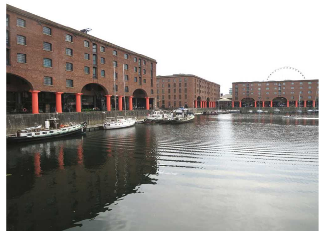
【写真2】 完全な耐火構造のアルバート・ドック、 赤の高さ4.5mの柱は鑄鉄製
