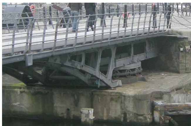
〔写真5〕 アルバート・ドッグの旋回橋の橋台 庫は、閉鎖された。
