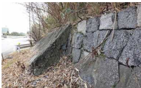
写真3 人造石護岸を覆うコンクリート護岸 (2021.2.7筆者撮影)
