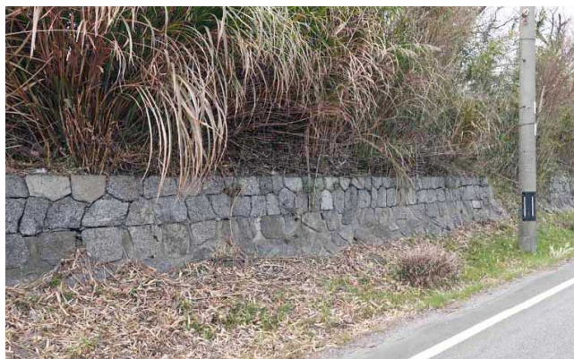
写真4 嵩上げと思われる高さ1.5mほどの石垣護岸 (上部2段は空石積み、下部は人造石) (2021.2.7筆者撮影)
