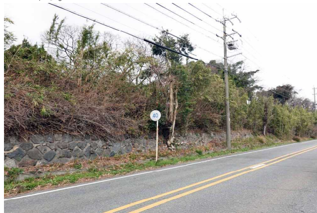
写真1 北側堤防の人造石護岸(竹藪も)(2021.2.7筆者撮影)
