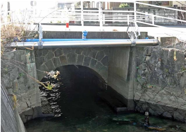
写真3 平坂樋門(平坂橋)の人造石樋管アーチと人造石護岸(上流側より、2020.12.13筆者撮影)
