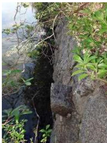
写真2 西小柳樋門脇の護岸割石の飛び出し (2020.10.14筆者撮影)
