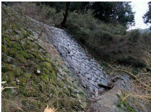
[写真9] 吉谷「下の砂留め」 巨石空石積堰 (2015/2/28)
