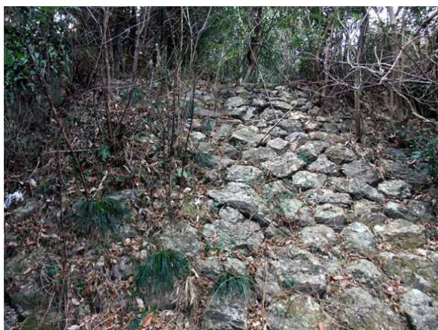
[写真3] 岩舟川支川1の④ 空石積落差工通水部表法面 (2014/2/7)
