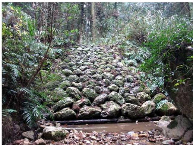
[写真2] 岩舟川支川1の② 空石積落差工 (2014/12/13)
