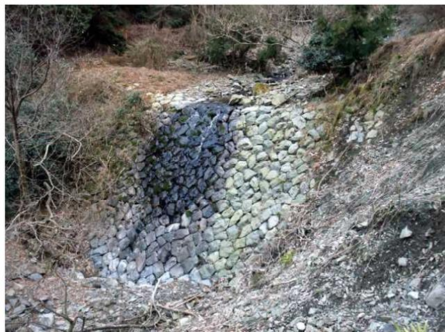
[写真11] 吉谷「上の砂留め」巨石空石積堰 (2015/2/28)
