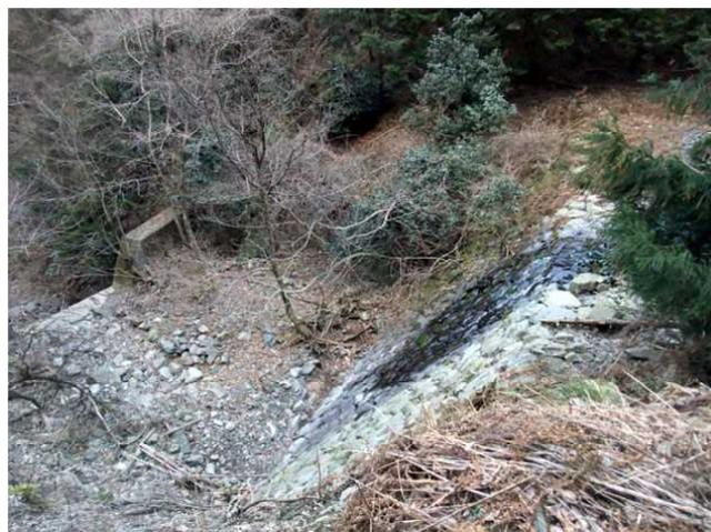
[写真12] 吉谷「上の砂留め」巨石空石積とその下流 (2015/2/28)
