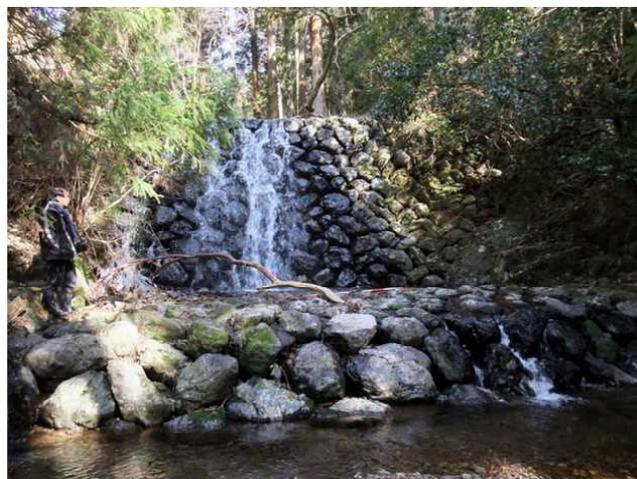
[写真4] 釜ヶ谷 (No35) 巨石空石積堰堤工
