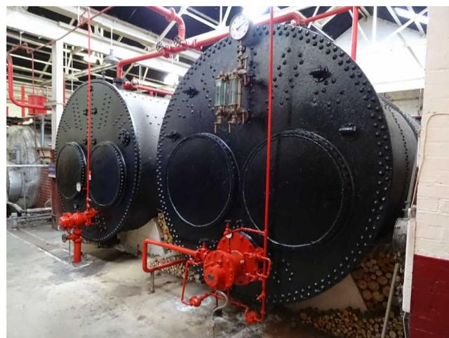
[写真10] 1908年に設置されたランカシャー・ボイラ、現在は石油タンクに改造されている
