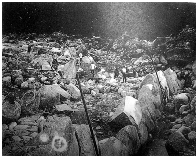
〔写真3〕 一の瀬空石積砂防堰堤施工状況か 『三重県砂防史』より複写 (2017/11/22、筆者撮影)
