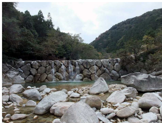
【写真2】 一の瀬空石積砂防堰堤
