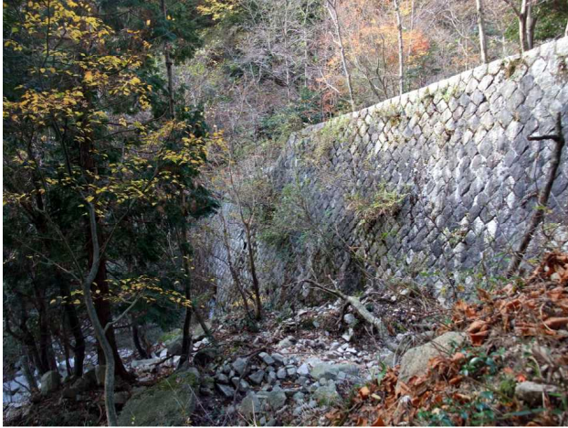
〔写真7〕 猫谷間知石積砂防堰堤
