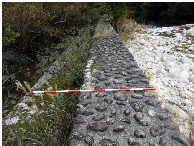
〔写真4〕 一の瀬空石積砂防堰堤左岸上流の導流堤)
