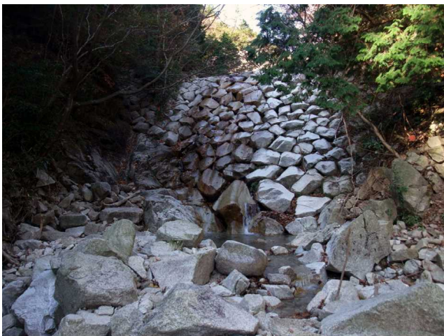
〔写真8〕 猫谷第2砂防堰堤
