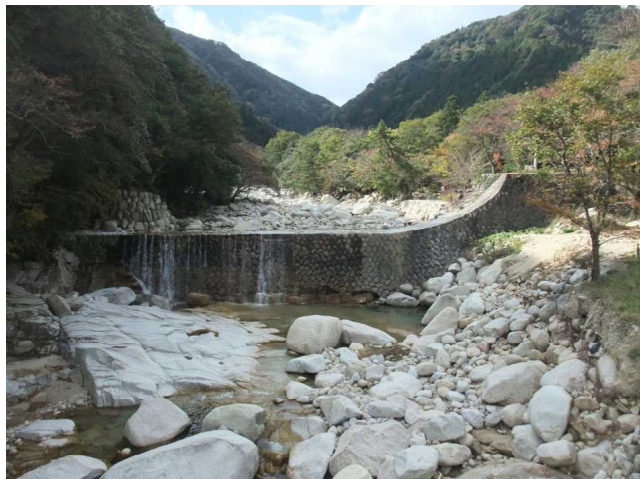
【写真1】 一の瀬練石積砂防堰堤 （2014/11/14、筆者撮影、以下同じ）
