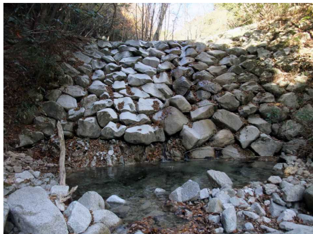
〔写真6〕 猫谷第1砂防堰堤
