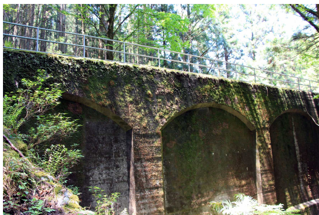
〔写真2〕中津川水路橋 （2013/05/04 柘植芳之撮影）
