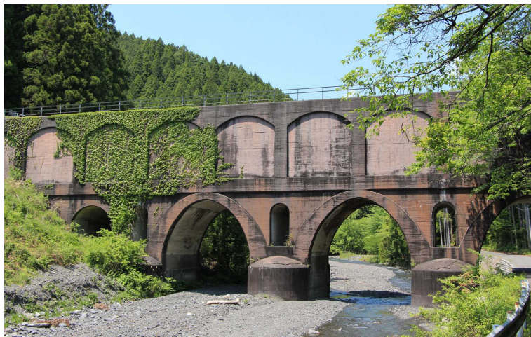
〔写真1〕長尾川水路橋 （2013/05/04 石田正治撮影）
