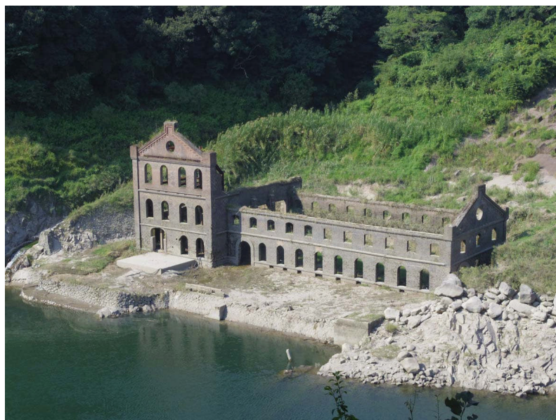
〔写真〕曾木第二発電所本館の遺構 (2013/09/23 稲森龍一撮影)
