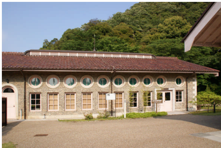
〔写真1〕旧ポンプ室 (2009/06/06 筆者撮影)
