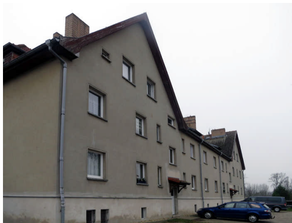
[写真2] Funkerhausの背面 (2014/12/03)
