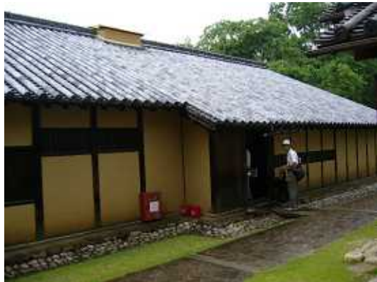
写真1 鑄造工場の入口
