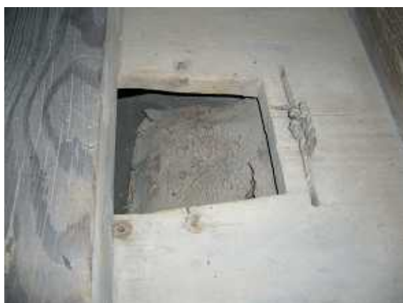
写真9 革が張られた吸気弁
