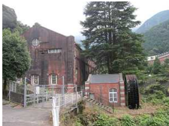
旧端出場水力発電所
