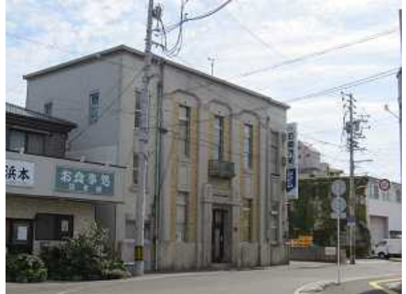
石崎汽船本社建物
